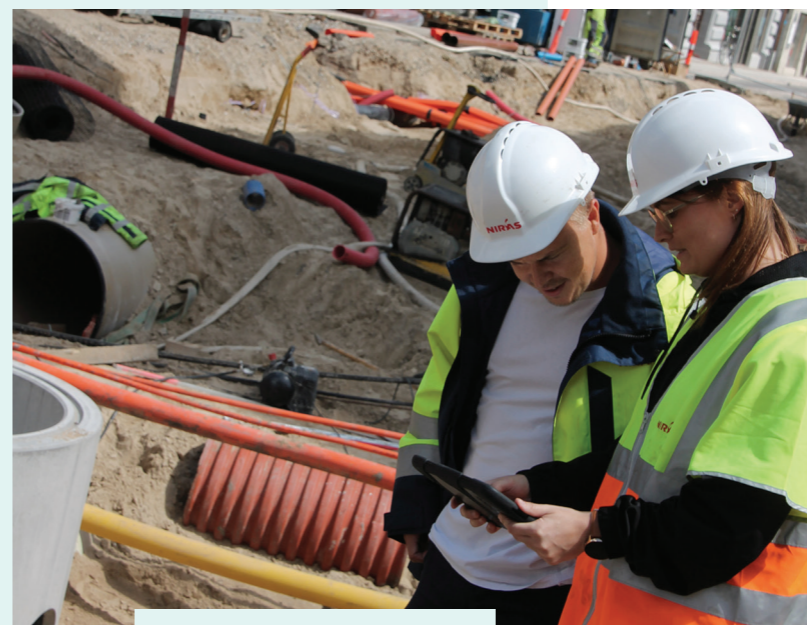
Paradigmeskifte i ledningsrenovering kræver veldokumenteret planlægning
